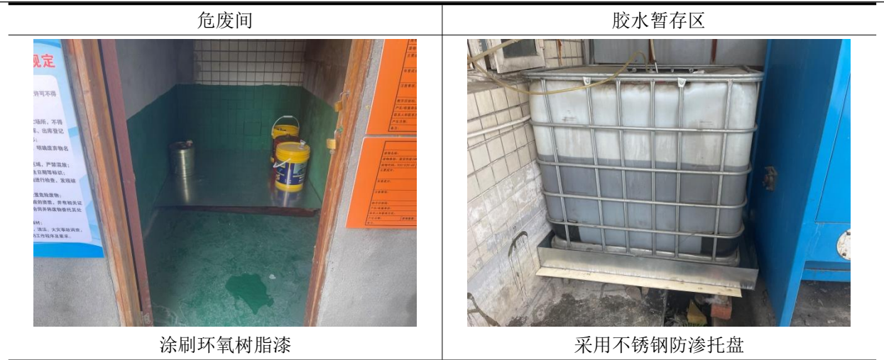
图 9 地下水防渗措施照片
